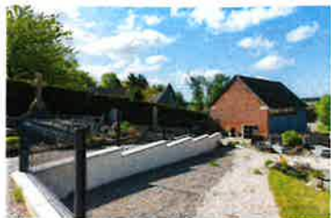
Vue générale du côté est du cimetière depuis l'entrée nord. Phot. Marc Kérignard IVR32_20236000607NUCA
